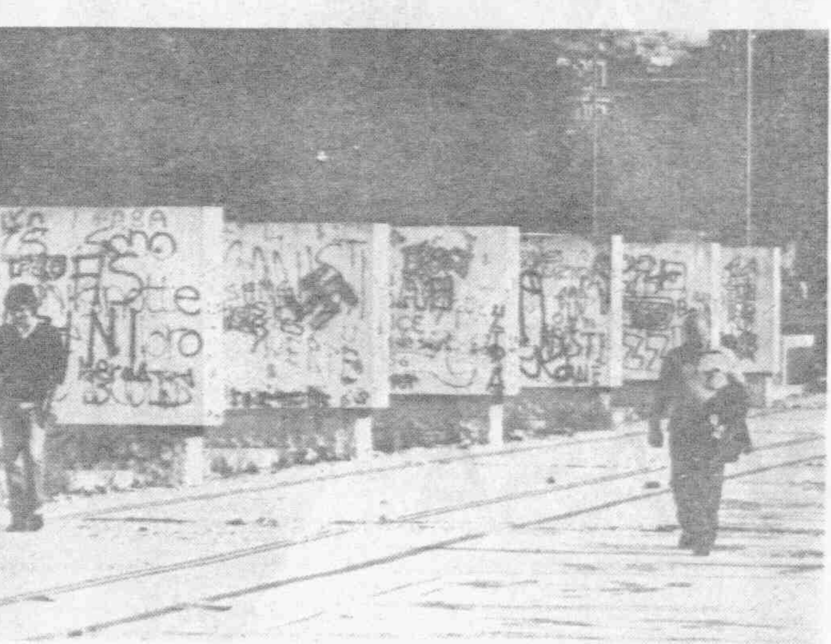
Ecco com'è ridotto il monumentale ingresso al Foro Italico
